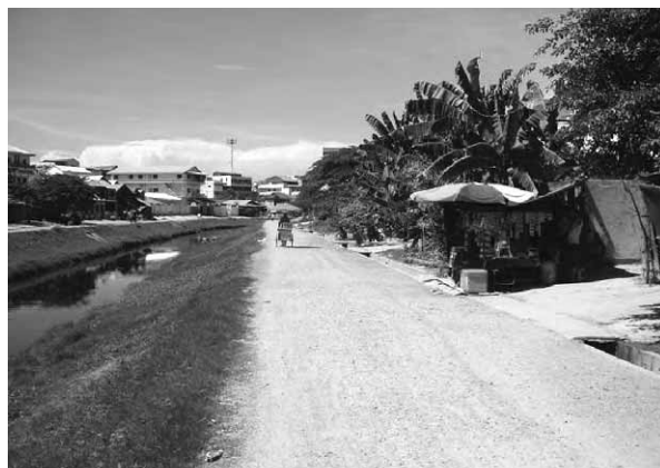
写真 - 3 フェーズ1事業により完成した排水路管理用道路上にできた商店
