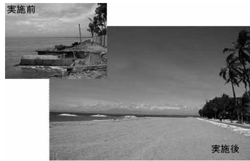
養浜 + 離岸堤による砂浜の復元 (クタ)
