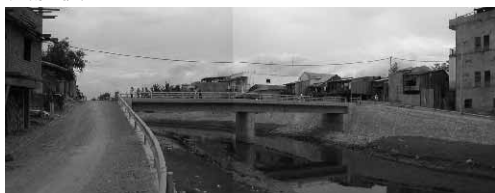
写真 - 1 フェーズ1事業により完成した排水路と橋梁
