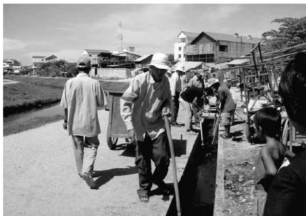
写真 - 2 フェーズ1事業により完成した排水路管理用道路の側溝の住民による清掃活動
