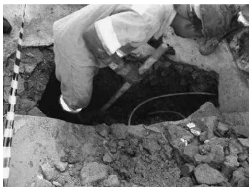
給水管の布設工事
